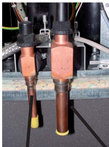
Flüssigkeitsleitung Heißgasleitung Kältemittel (12x0,8mm) Kältemittel (18x1mm)
